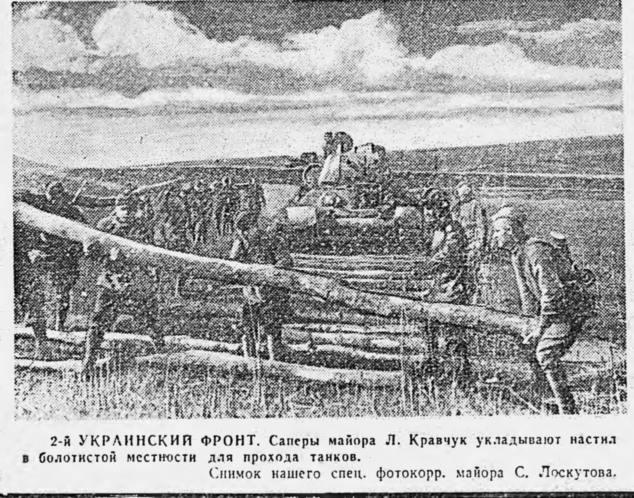
2-й УКРАИНСКИЙ ФРОНТ. Саперы майора Л. Кравчук укладывают настил в болотистой местности для прохода танков.
