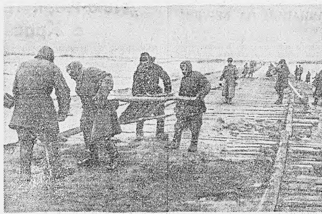
1-й БЕЛОРУССКИЙ ФРОНТ. Строительство гати через болото. Снимок нашего спец. фотокорр. О. Кнорринга.
